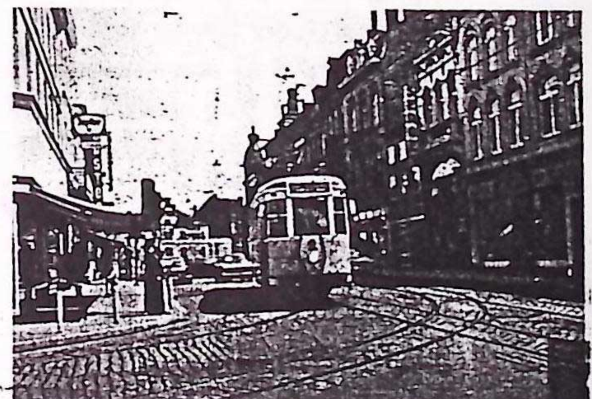
Le tram 33 au lieu-dit « Drapeau Blanc » à La Louvière.
